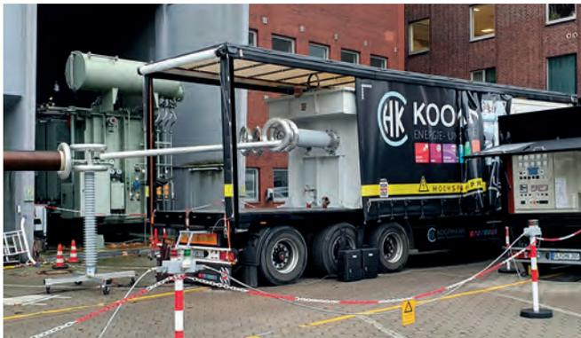
260 kV Resonanzprüfsystem
